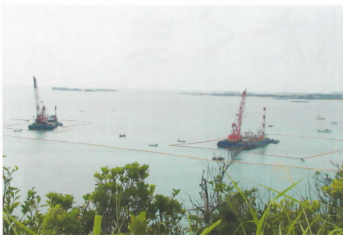
▲ 大浦湾にコンクリートブロックを落とす作業台船
